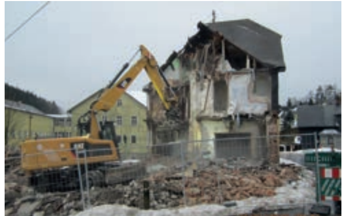
Die Gebäudeabbrucharbeiten schreiten voran.
