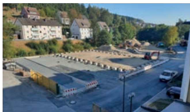
Freizeitanlage im Bau (Stand 15.9.2020)
