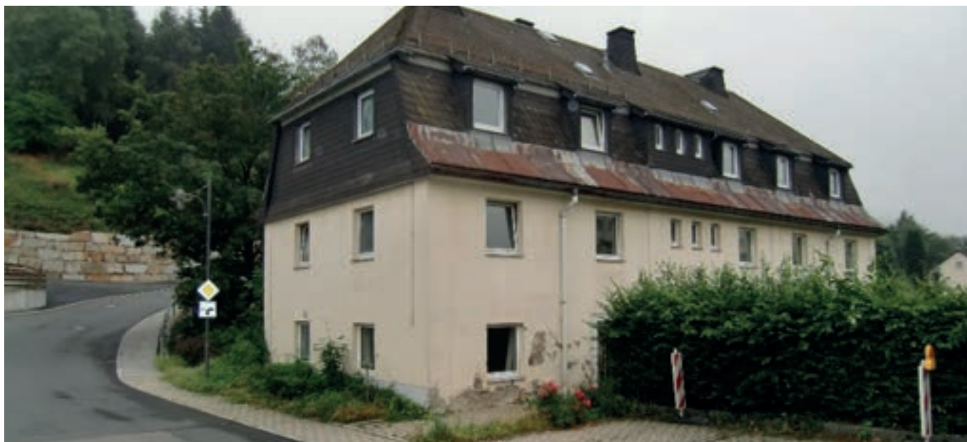
Siedlungsstraße 6 - ursprünglicher Bestand
