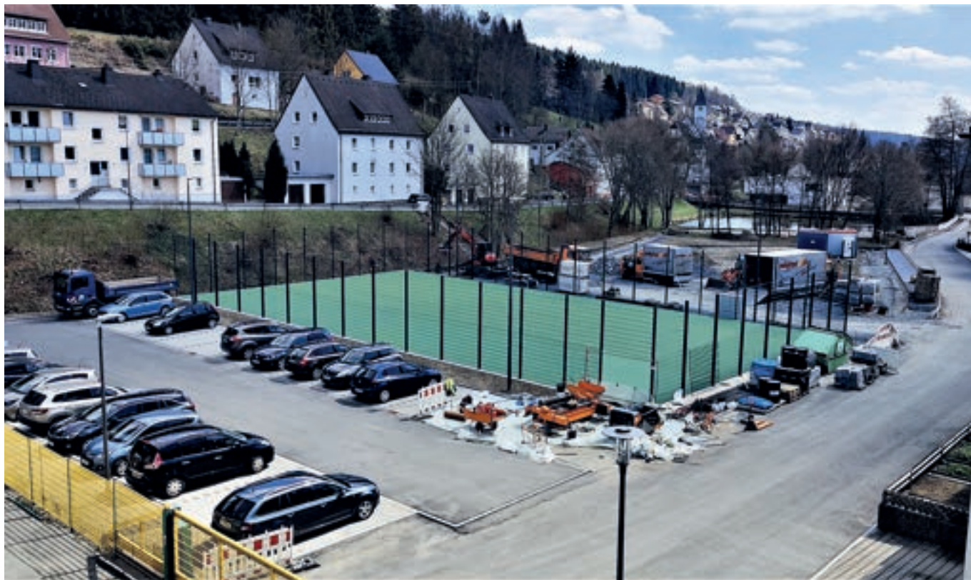
Freizeitanlage im Bau (Stand: 26.4.2021)
