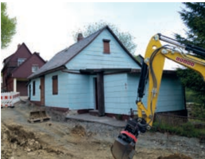
So sah es vorher aus. Das Gebäude wurde abgerissen.
