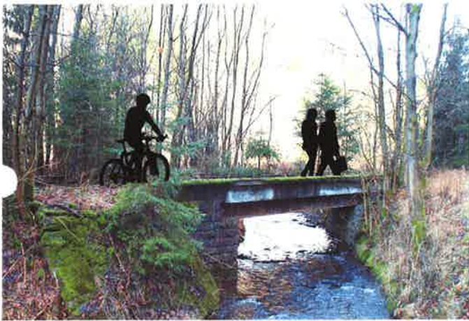
Die ehemalige Bahntrasse als Verbindung nach Alexanderhütte
